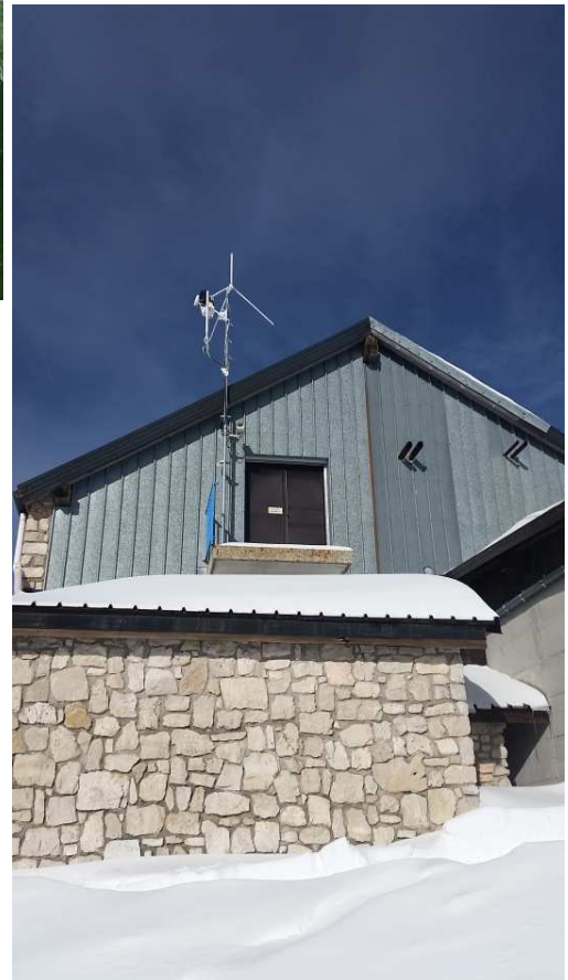
Vista del sito monitorato
